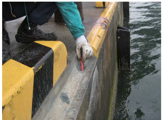
④孔内を吸引又はプロアー・ブラシを使用して入念に清掃し、ケミカルカプセルを挿入してください。
