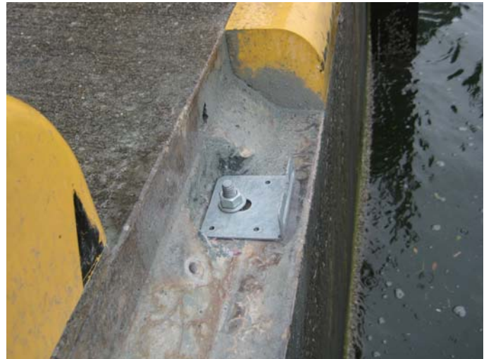
⑥固定用プレートをセットしナットで固定してください。 (仮締めにしておき、本体セット後に固定します)
