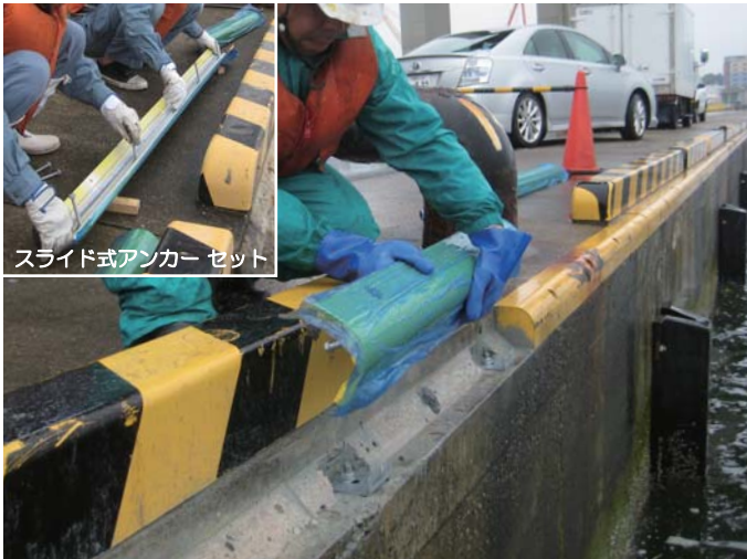
⑦スライド式アンカーを定位置にセットします。 本体側面の固定用孔に固定用金具をセットし、本体を固定用プレートにはめ込んでください。
