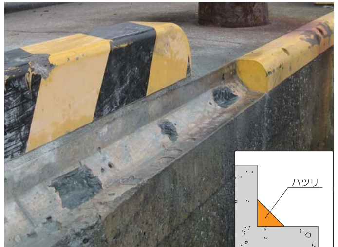
②既設岸壁で、固定用プレートとスライドアンカーがくる位置のハツリを行ってください。
