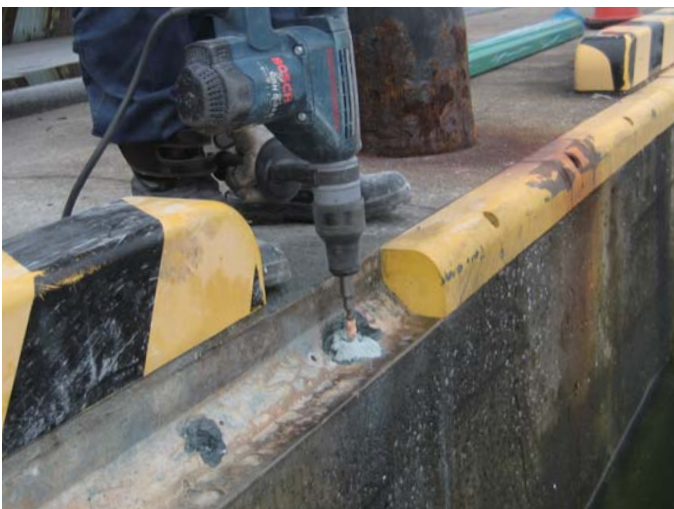
③実際に使用するコーナー材の固定孔位置に合わせて位置出しし、φ15mm×110mmの寸法で削孔してください。
