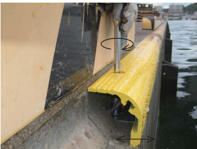
⑨法線を決定し、天端面の充填確認孔からソケットレンチを使い固定して下さい。
