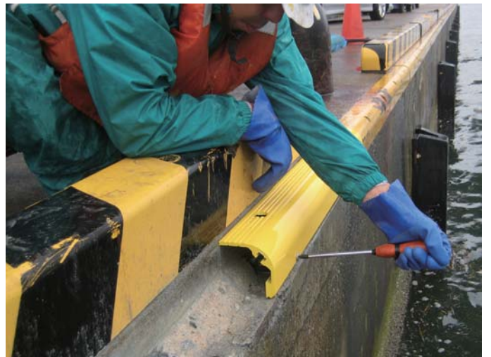
⑧側面からトラスビスを締めつけ、本体を固定して下さい。
