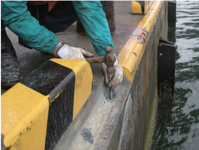
⑤ハンマーでアンカーボルトを110mmの深さまで打込んでください。
