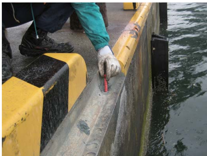
④ 孔内を吸引又はブロアー・ブラシを使用して入念に清掃し、ケミカルカプセルを挿入してください。
