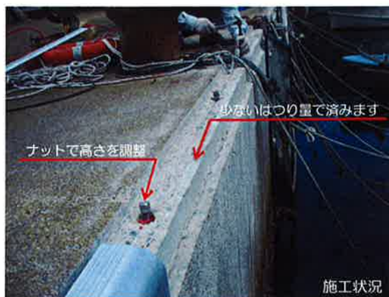
供用中の岸壁で施工
