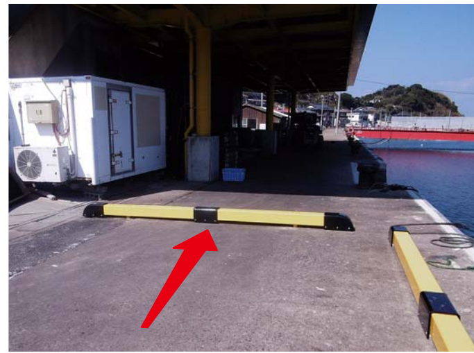
移動後：荷役時の外部車両の進入を防ぐ。
