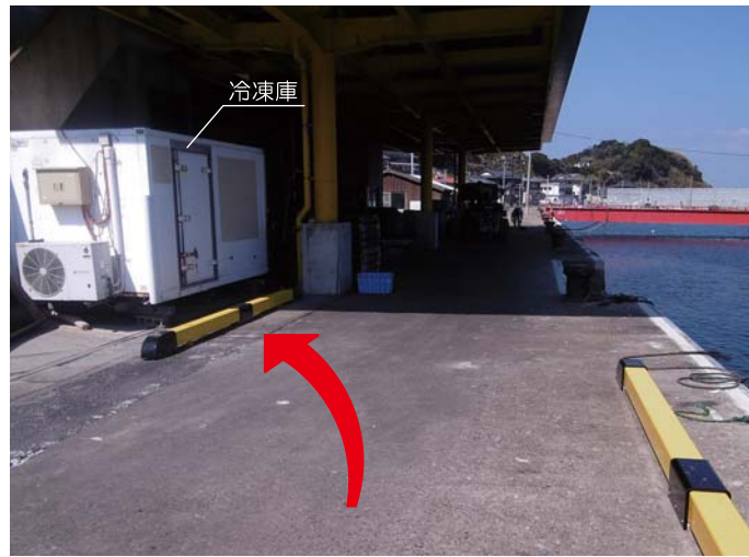
通常時：車両の冷凍庫への衝突を防ぐ。
