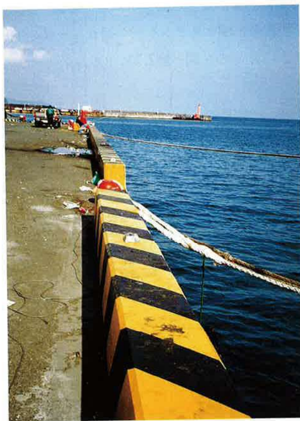
幅40cm 高さ50cm 清水港（静岡県）
