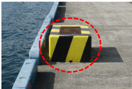
図 4.27 岸壁上に突出した給水設備
