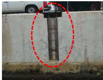
図 4.30 岸壁側面の切込み部に設置されたはしご (安全性向上事例)
