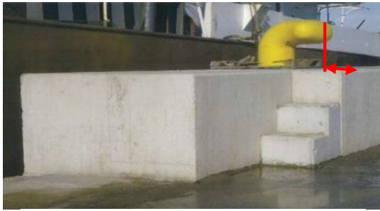
図 4.7 係船柱の嵩上げ①
