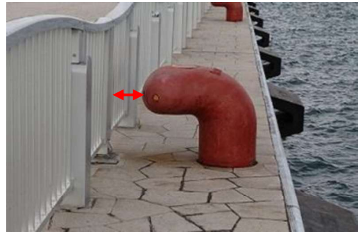
図 4.4 フェンスの近接
