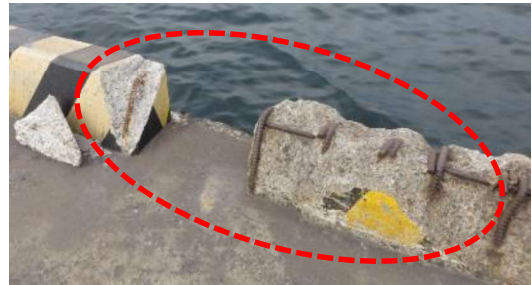
図 4.35 天端が欠けた車止め
