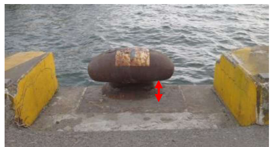
図 4.10 係船柱の胴部の高さ
