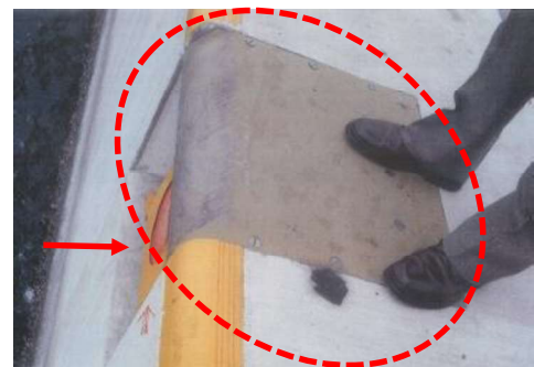
図 4.24 岸壁箱抜き部への岸照灯及びカバーの設置 (安全性向上事例)
