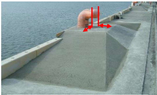
図 4.8 係船柱の嵩上げ②
