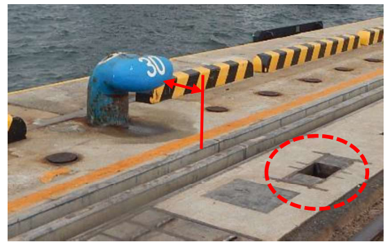
図 4.5 荷役機械用の溝や箱抜きの近接
