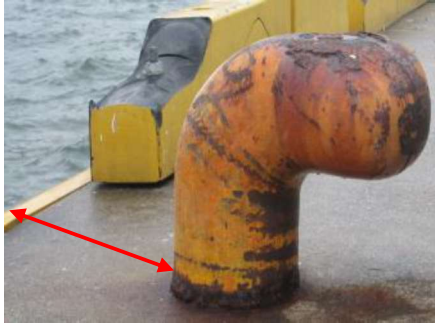
図 4.1 係船柱の配置
