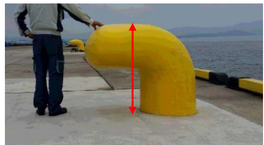
図 4.11 係船柱の高さ
