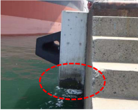
図 4.17 防舷材のコンクリート製の台座
