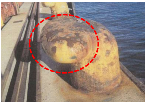
図 4.9 係船柱の頭部の出幅
