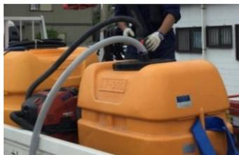
**バキュームクリーナーによる汚泥水回収(タンクへの直結仕様)**
