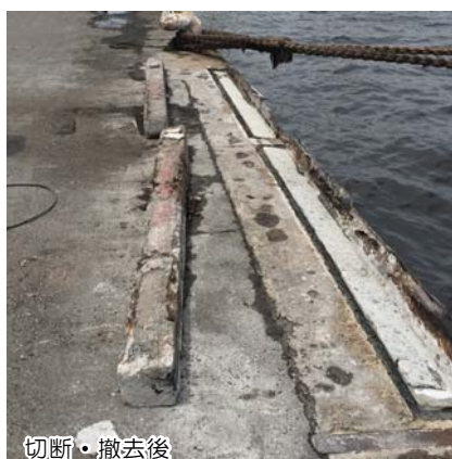
切断・撤去後
