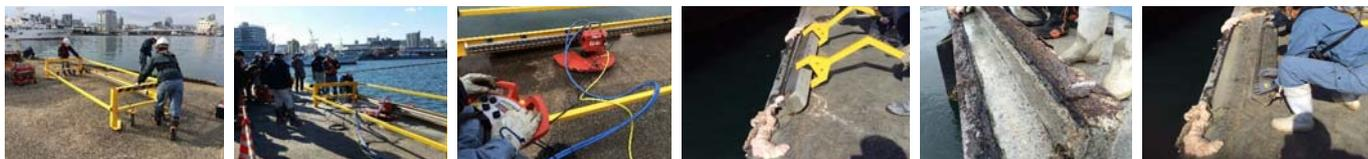
車止めの取替え工事で施工業者様が長年苦勞されていた被覆鋼板製車止めの撤去作業。これを何とか改善できないかと1年間試行錯誤を繰り返し、ようやくその答えが見つかりました。その名は「スラッシュカット工法」です。
