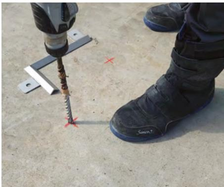
車止めを据えた状態でキャスターストッパーの位置決めと墨出しを行い、Φ15mm × 105mmの寸法で削孔してください。
