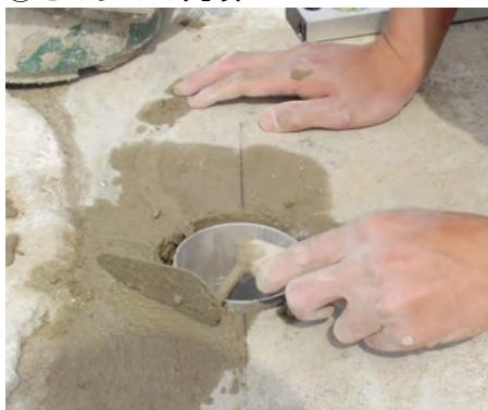
スリーブ管を入れ、通りの調整を行なった後、すき間に流動性の良いモルタルを充填してください。
