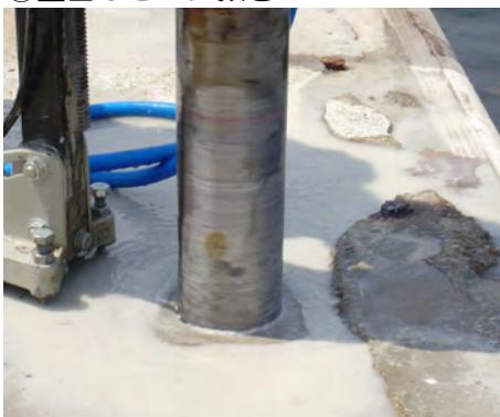
車止め法線、固定用支柱の中心を墨出し、下記の表を基に所定寸法にてコア抜きを行ってください。
