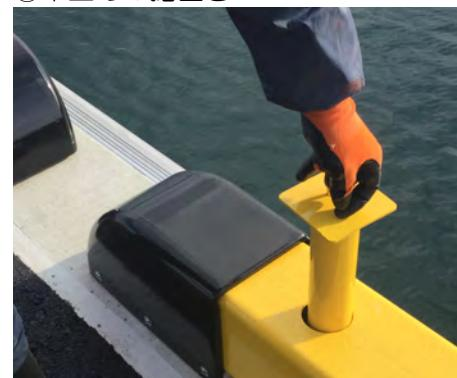
モルタル硬化後、車止め本体の固定用支柱とスリーブ管位置が同位置であることを確認し、固定用支柱を差し込んでください。
