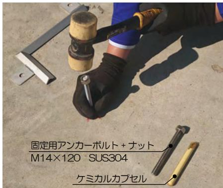
孔内をプロアー等で清掃し、ケミカルカプセルを挿入後、ハンマーでアンカーボルトを105mmの深さまで打込んでください。
