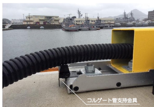
エンドカバーの一部は加工を施し、管の支持部となります。
